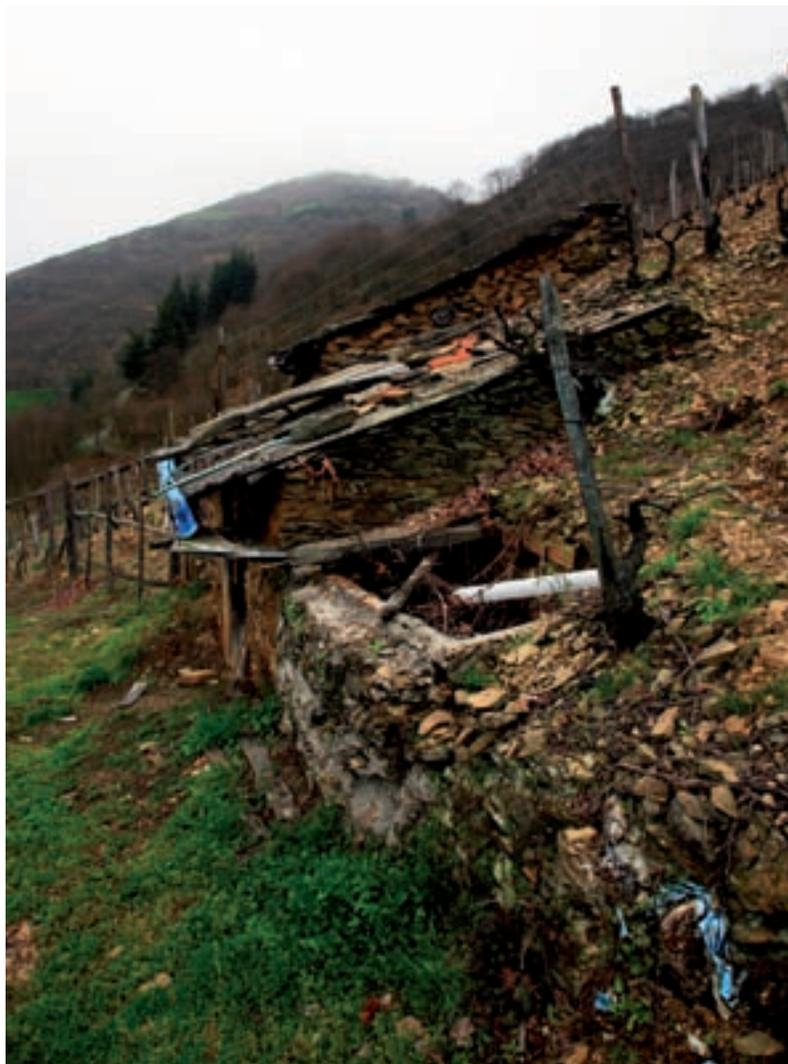
Depósito de almacenaje de aguas recogidas de la escorrentía del tejado. Puenticiella. Limés.
